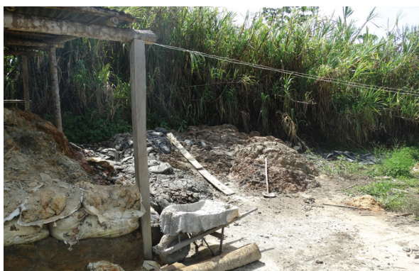
Figura 13. Pila de material con aislamiento.
