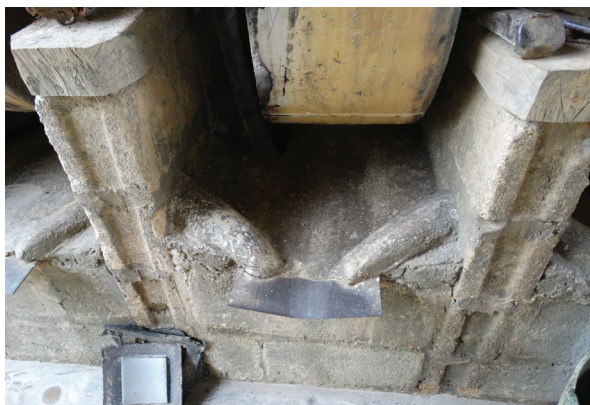
Figura 12. Canal de descarga.
